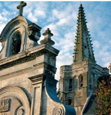
■ MINGOVAL. Pour faciliter la réparation des flèches en pierre celles-ci sont construites en retrait de la tour pour permettre la circulation autour de leur base. De même les arêtes de la flèche sont garnies de crochets dont le dessus est plat pour y faire reposer les échafaudages. © Cituation & Ensemble
